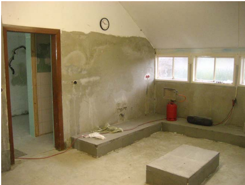
Die neue Küche, Blickrichtung Westen.
